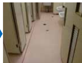
床面のメタクリル樹脂コーティング
