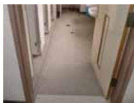
床面のメタクリル樹脂コーティング
