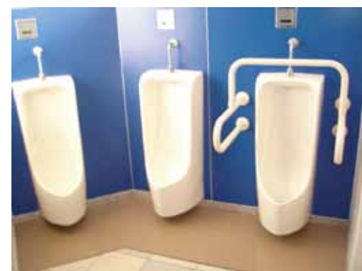
▲受け部が低い（低リップ）壁掛け式小便器と汚垂（おだれ）石のある男子トイレ（清和小学校）
