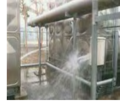
高エネルギー加速器研究機構 (受水槽の破損)
