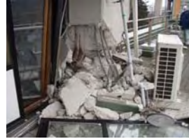
東北大学(柱の破壊)
