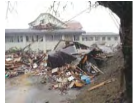
東北大学(建物の損壊)
