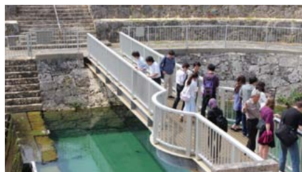
宮古島におけるオンサイト実習では離島におけるインフラを学びます(写真は浄水施設)
