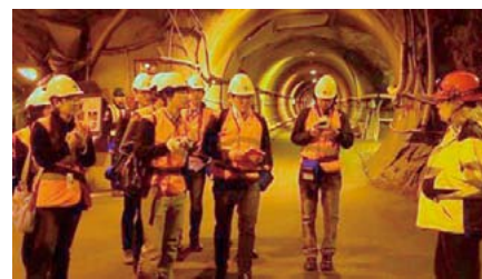
使用済燃料処分のための450m地下研究施設(スウェーデン)
