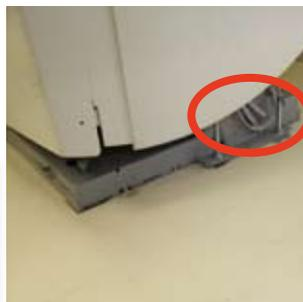
重量のある機器類は、アンカーボルトを用いて床や壁に直接固定します。また、固定位置のバランスが悪いと固定ボルトが地震動で抜けてしまうこともあるので注意が必要です。
