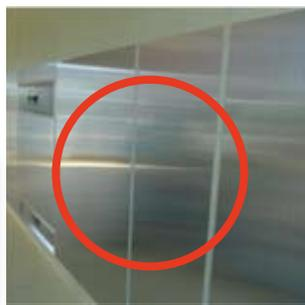
キャスター付きの機器・什器が動き回って壁にぶつかっても、壁面が傷付かないように保護する部材を貼り付けます。
