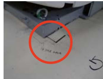
▲CTスキャンなどの重量物でも床や壁にアンカー固定されていないと移動
