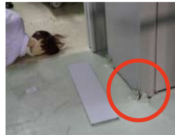
▲350～400kgの重量のあるヒュームフードや実験台が、地震の衝撃で移動
