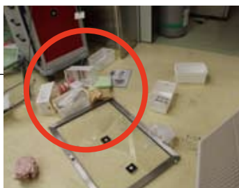
▲埋め込み式戸棚の扉・棚板が脱落し、中身が散乱
