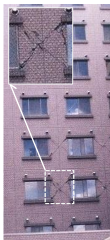
写真 1: ×印のひび(剪断破壊)
