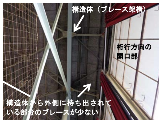
写真 37 桁行方向の開口部の屋根ブレース ※全景写真は 2-3-1 参照
