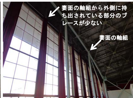
写真 28 妻面の開口部の屋根ブレース
