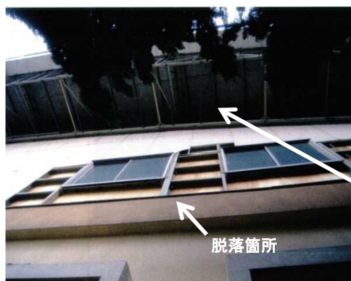
写真 36 外装材（フレキシブルボード等）の脱落
