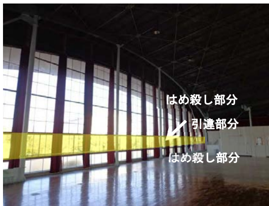
写真 27 妻面の開口部（復旧後）
