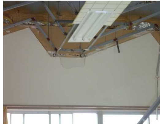
写真 11 段差・折れ曲がり天井の脱落
