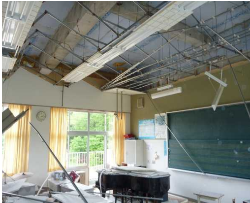
写真 11 段差・折れ曲がり天井の脱落
