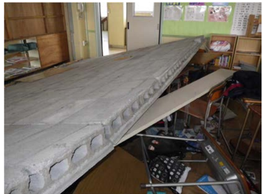
写真 23 RC 造架構との境界部分
