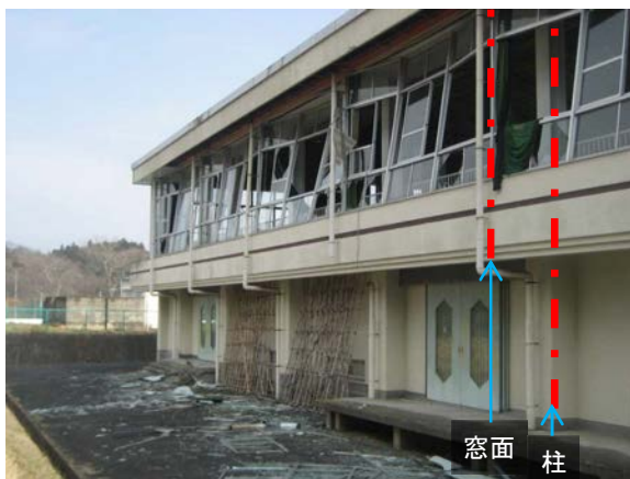
写真 6 桁行面の窓と柱の関係（例）
