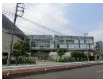
校舎全景(北面)
