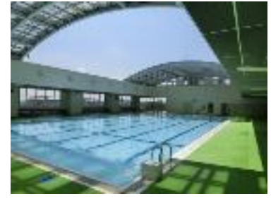
開閉ドーム付きの 屋上プール
