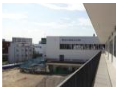
2階テラスと屋内運動場、屋外階段
