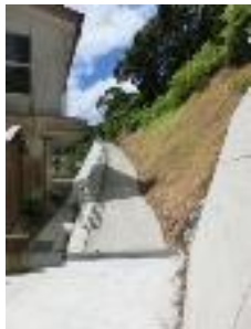
屋外避難階段(スロープ部分)
