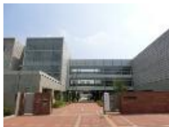
校舎全景(北面)
