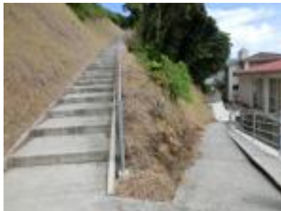
屋外避難階段(踊り場)
