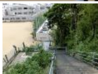
屋外避難階段(校庭を望む)
