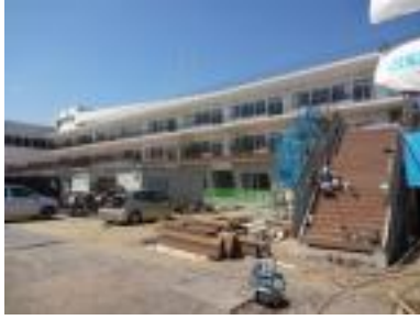
屋外階段と繋がる2階テラス
