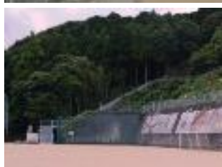
屋外避難階段全景
