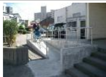
①スロープの設置
