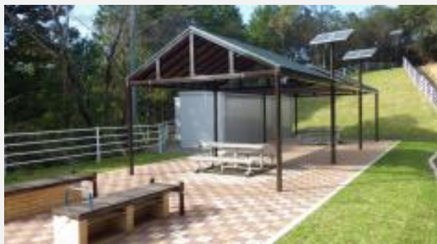
東屋と備蓄倉庫、ソーラーライト
