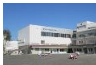
①②2階の屋内運動場と屋外階段 (江戸川区提供)
