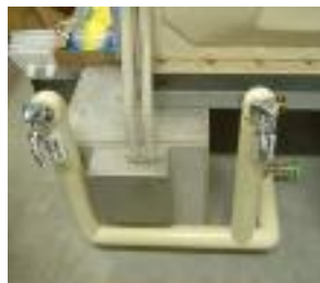
④受水槽への蛇口の設置
