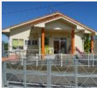
敷地境界フェンスに設置した門
