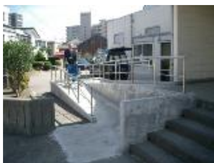
①スロープの設置
