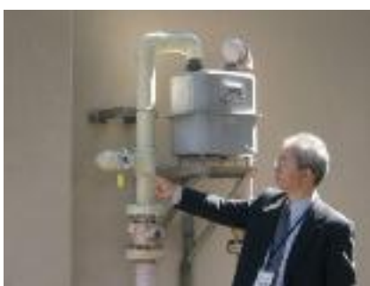
⑤LP ガスから都市ガスへの変換器の接続口
