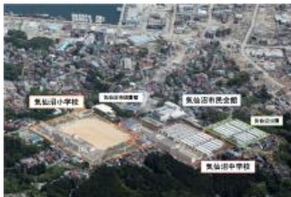
3施設周辺の震災後の空中写真（国土地理院提供）
