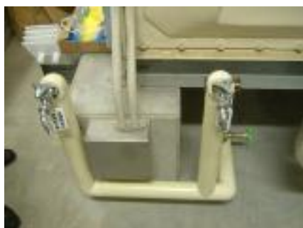
④受水槽への蛇口の設置
