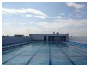
⑧屋上に設置したプール
