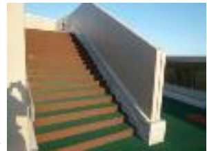
二次避難スペース への屋外避難階段
