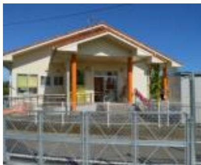
隣接する保育所との間の敷地境界 フェンスに新たに設置した門
