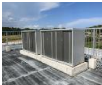
屋上の備蓄倉庫（竹島小学校）
