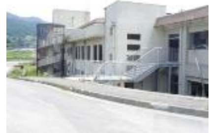
校舎2階と市道をつなぐ屋外非常用通路(上野淳委員提供)
