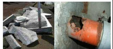
(左)落下したモルタル (右)劣化による配管破損
