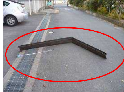
老朽化した屋根材の一部が 強風により剥離（築26年）
