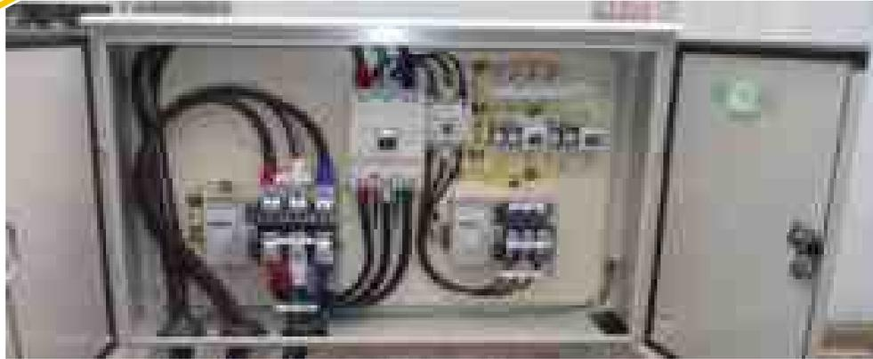
停電時に発電機を持ってくることにより、アリーナの照明やコンセントに電源を送ることができます。
