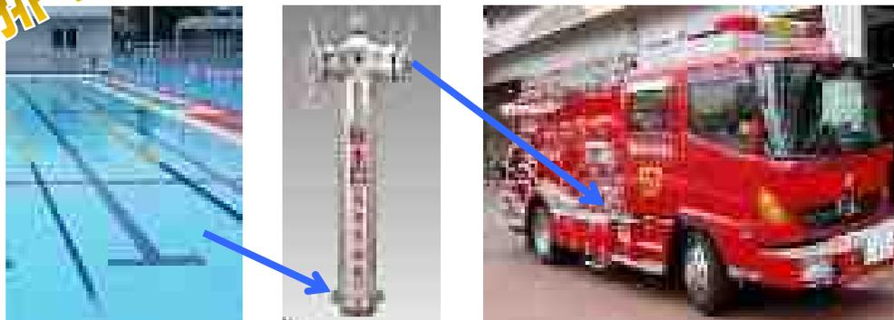
屋上プールの水は、校門近くの消火栓まで繋がっています。近所で火事が発生したとき、消防車がこの消火栓からプールの水を利用して消火活動ができます。
