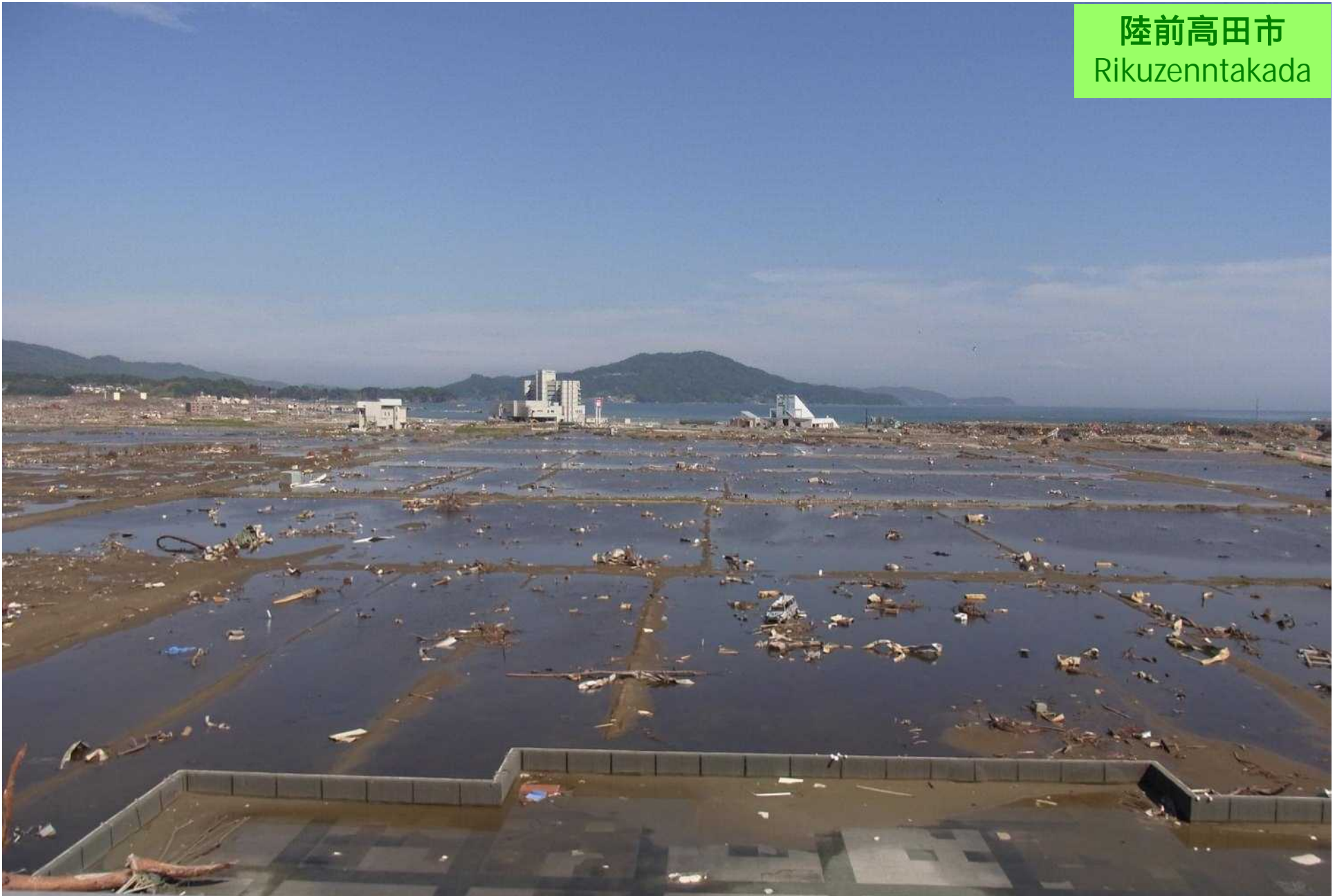
壊滅した県立高田病院：屋上からの市街地 view from the rooftop of the hospital
