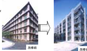
改修前 改修後 大阪大学(基礎工)校舎改修
