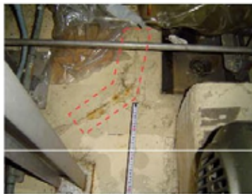
③ひび割れ (w=0.2mm、L=450mm)
