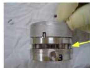
カラー（セトスクリュー取付け部③） （セトスクリューが外れていた）
