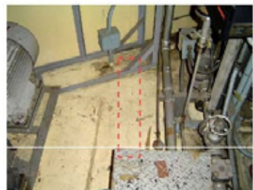
④ひび割れ (w=0.15~0.3mm、L=3700mm)
