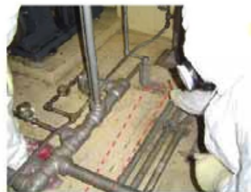
⑥塗装の割れ (埋め込み金物とコンクリートの境界部)
