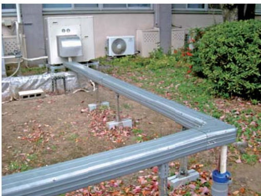
実証中の直膨方式地中熱ヒートポンプ
