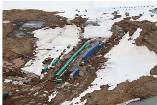
新設したコンテナヤード(206m×17m)中央 多雪の影響で、コンテナヤードまで雪上車と橇でコンテナを輸送することになった。アルミデッキで改修したヘリポート(28m×25m)しかし、左上 51 次隊では残雪が多く、アクセス道路が十分使用できなかった。
