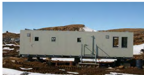
新設したヘリポート待機小屋(11.9m×4.7m)
