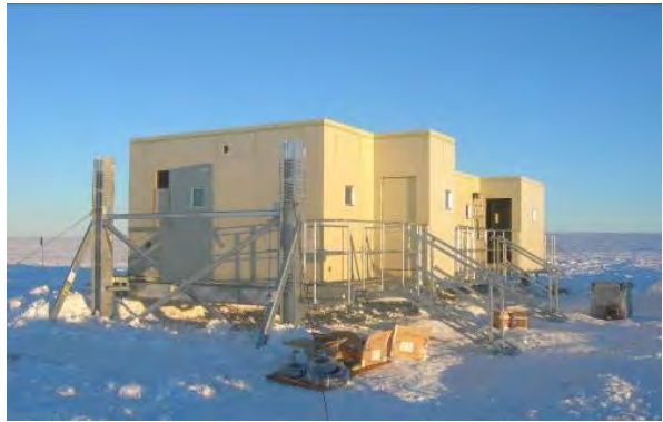
47 次隊で建設した S17 地点ジャッキアップ式建物の支柱を追加しドリフト軽減対策を行った。(48 次隊)
