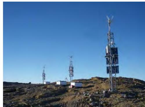
図4 西オングル島に設置された風力発電装置。通年にわたり数10ワットの電力供給が可能なが実証された。
