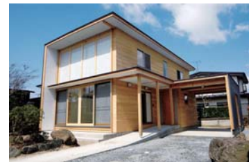
木ダボ接着接合を用いたラーメン構法で建設した住宅
