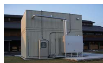
木材乾燥養生庫
