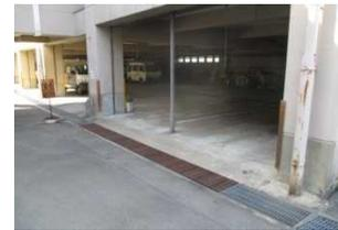
耐車荷重側溝グレーチング
