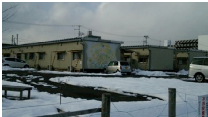
あすと長町仮設住宅団地
