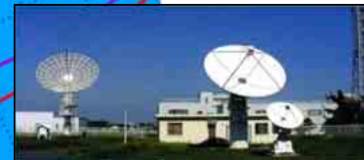
平磯太陽観測施設
