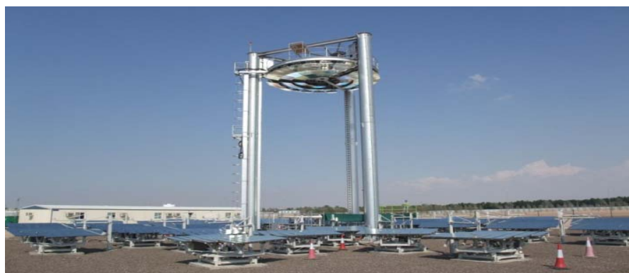
タワー型太陽熱発電技術実証実験プラント（アブダビ、UAE）
