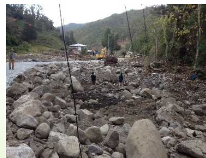
写真 鼠入川、写真右手前から奥に流下、河岸を超えて土砂が堆積
