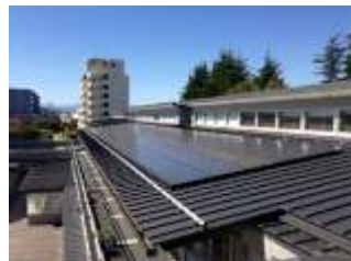
多摩第一小学校の太陽光発電
