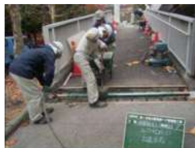
橋りょうの 補修工事
