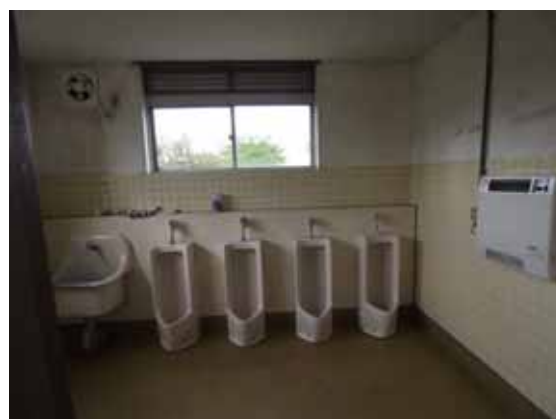
写真．トイレ（踊り場）
