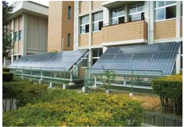
グラウンドから見える太陽光発電設備（南越小）
