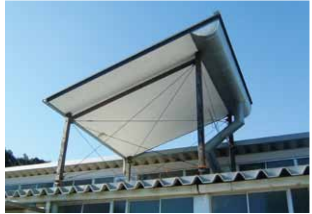
実習棟に設置されたシステム (掛川工高)
