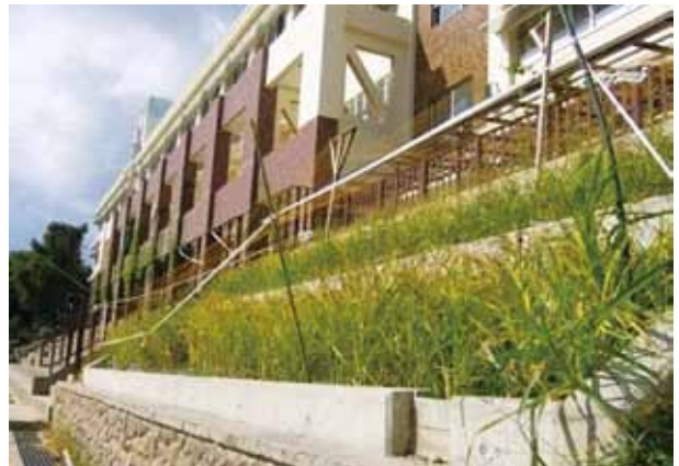
グラウンドへの斜面を利用したエコファーム（多聞東中）
