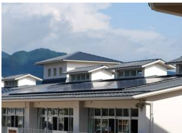
電力供給のために校舎屋根上に設置した太陽光発電
