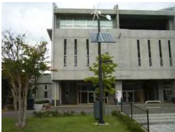
(北新庄小学校 太陽光、風力を利用したハイブリット型発電機付ライト)
