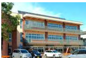
今町小学校（約6kw、屋上に設置）
