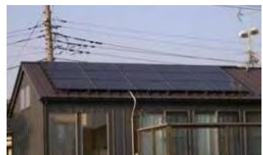
(屋根の上に取り付けられた太陽光パネル)
