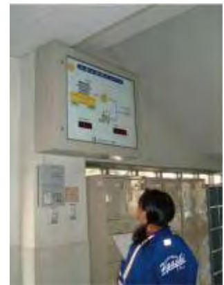
(発電量を調査する様子)
