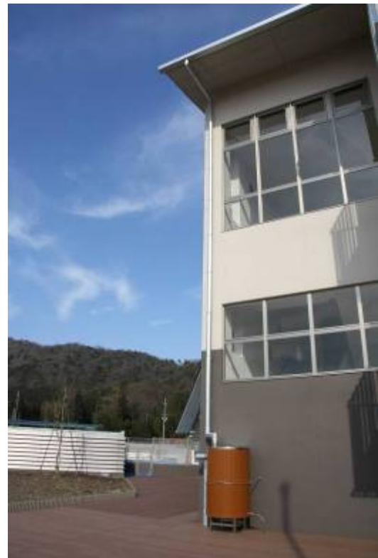
(雨水貯留タンク)
