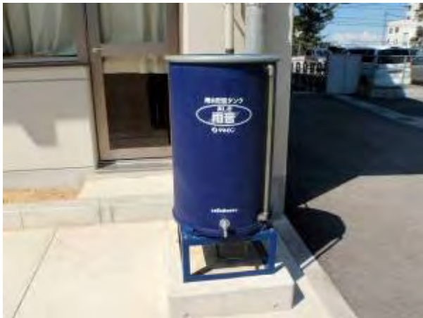
(雨水貯留タンク)
