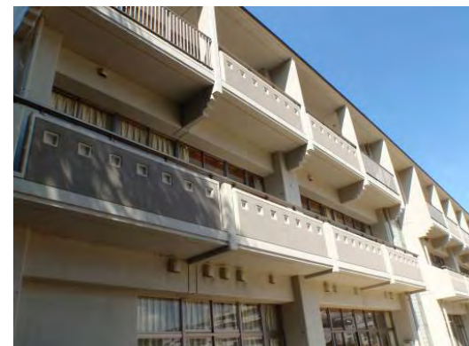
(日除けとして設置されたバルコニー)
