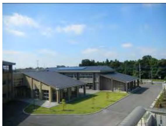
普通教室棟から見た太陽光パネル
