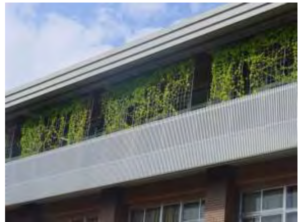
理科室バルコニーの緑のカーテン
