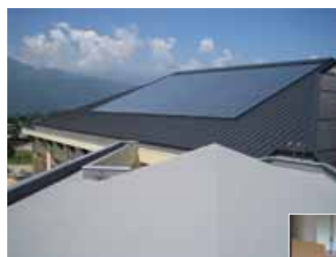
校舎屋根 (太陽熱空気暖房集熱パネル)
