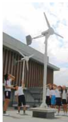
風力発電設備
