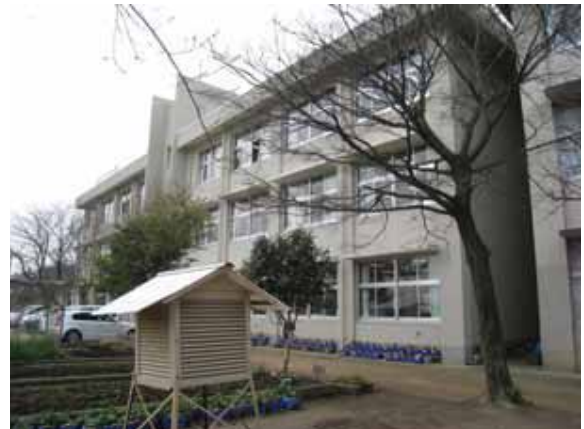
校舎南東側外観 (改修後)
