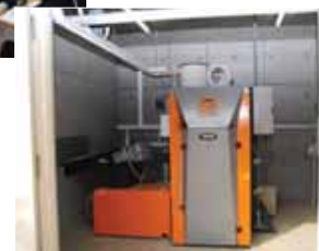
ペレットボイラー
