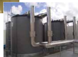
空調用氷蓄熱槽
