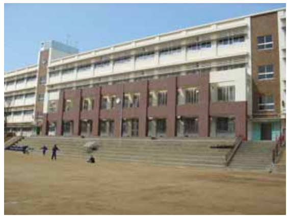
校舎南側外観（改修後）
