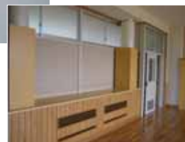
普通教室 (太陽熱空気暖房の吹き出し口)
