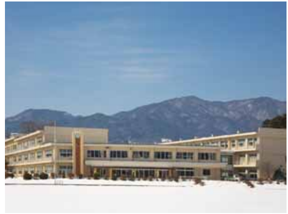
校舎全景 (改修後)
