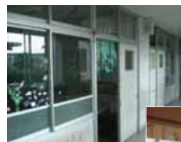
1階教室 (改修前)
