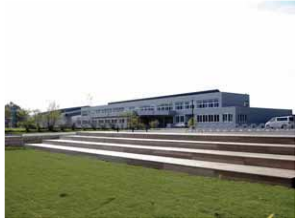
校舎南側外観 (改修後)
