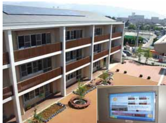
校舎南側外観 (増築後)・中庭
