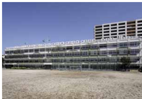
校舎全景（改修後）
