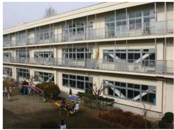
校舎南側外観 (改修後)
