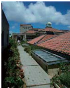
周辺環境に配慮し、地域特有の赤瓦葺屋根を使用した低層の校舎 (那覇市立城西小学校)
