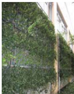
壁面緑化 (杉並区立荻窪小学校)
