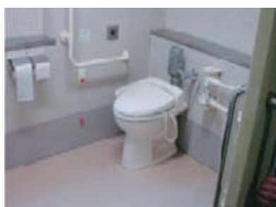
手すりを設けたトイレ
