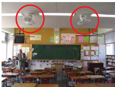
扇風機（天井に設置）
