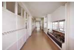
内装改修 (内断熱)
