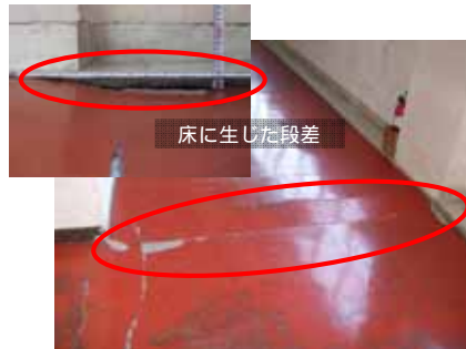
床の陥没による転倒の危険性
