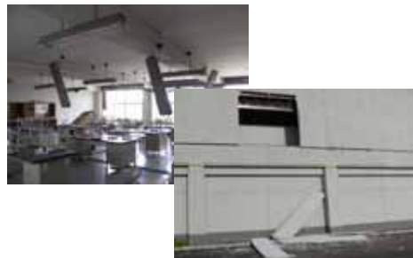
非構造部材（天井材、照明器具、外壁など）の落下の危険性
