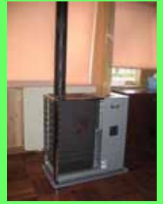
< 岐阜県高山市立北小学校 > 木質ペレットを燃料とするペレットストーブ
