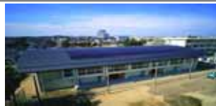
体育館屋根に設置
