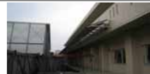
日射遮蔽機能を兼ねた庇型の設置
