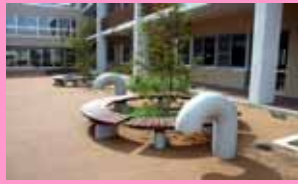
< 山梨県昭和町立西条小学校 > 地中熱導入アースチューブ
