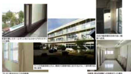
(エコ改修の状況)
