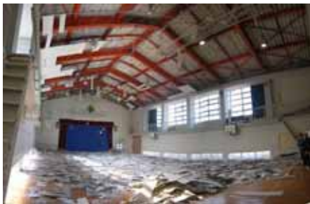
非構造部材（天井材、照明器具、外壁など）の落下の危険性
