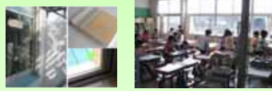
外断熱と複層ガラスの導入により、少しの暖房で温かい教室になったことを体感
