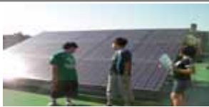
校舎屋上に設置
