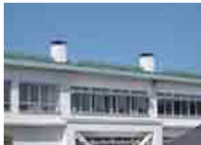
写真4-6 断熱化、雨漏り対策として、耐震補強と併せ設置された置き屋根
