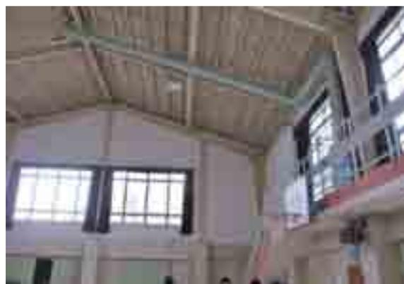
写真3-13 屋根裏からアリーナ床下へ暖められた空気を送るダクト。(薄緑色の配管)
