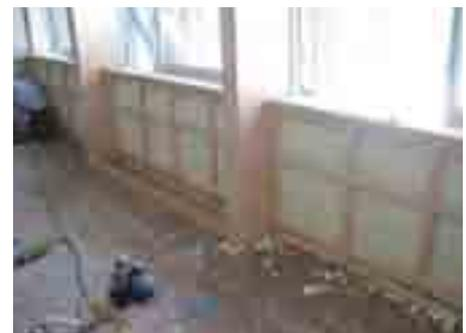
写真4-9 建物の熱性能の向上のため断熱化と併せて内装木質化
