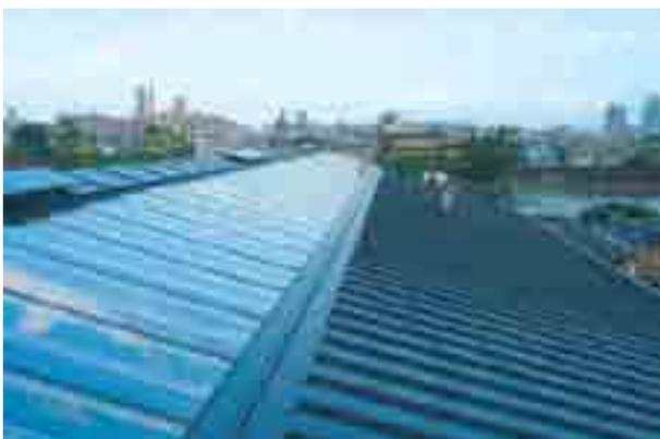
写真3-12 既存屋根仕上げの上を断熱化し、新規の集熱屋根を設置
