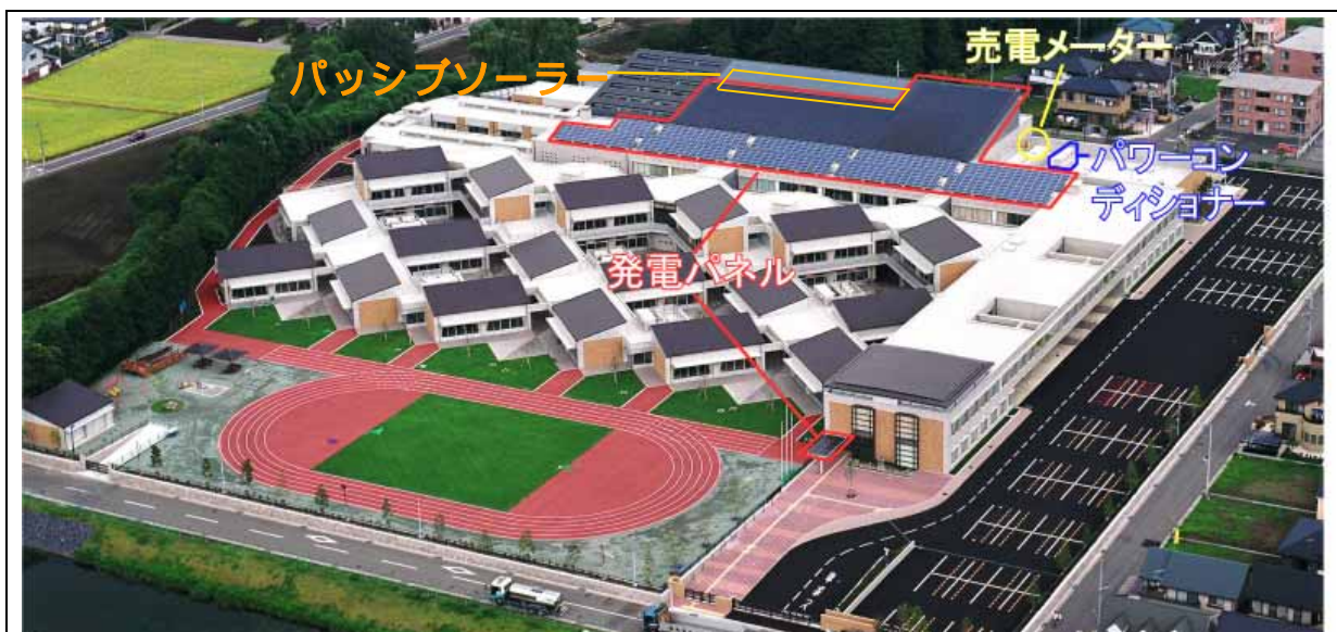
太陽光発電・パッシブソーラー設備の配置(航空写真)
