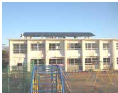
(新設した太陽光発電システム)
