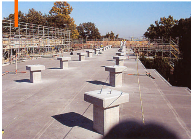
基礎工事完成
